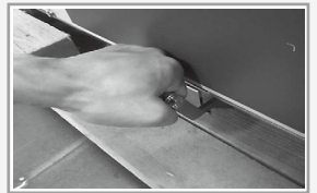
그림 4-2. Special GS type VCB 인출방법(2) Fig. 4-2 Withdrawing of the special GS type(2)
