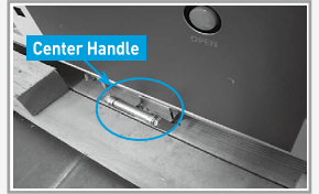
그림 4-1. Special GS type VCB 인입방법(1) Fig. 4-1 Insertion of the special GS type(1)
